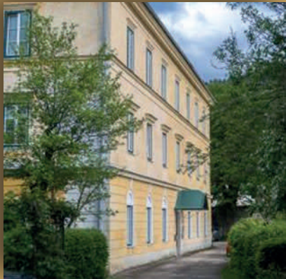
Das aufgestockte Stationsgebäude heute, Annastraße 1 © Franz Six
