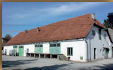
Die Westseite des Frachtenmagazins kurz vor dem Abriss © August Mayer
