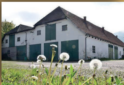
Das Frachtenmagazin mit den drei Einfahrtstoren vor dem Abriss © August Mayer
